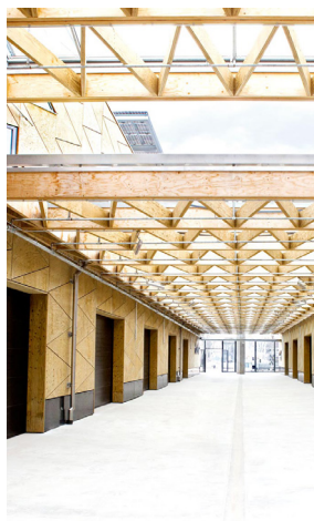
Greenbizz, Brussel - België Architecte Assoc+
