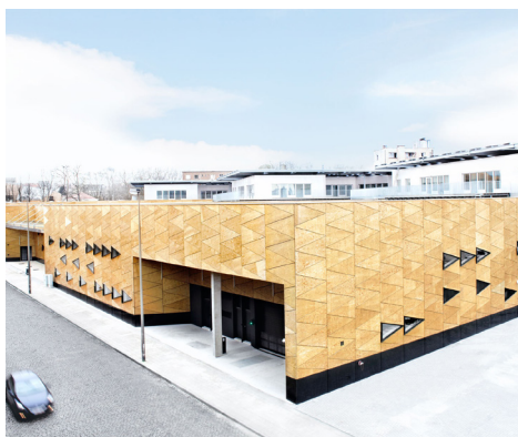
Greenbizz, Brussel -België Architecte Assoc+
